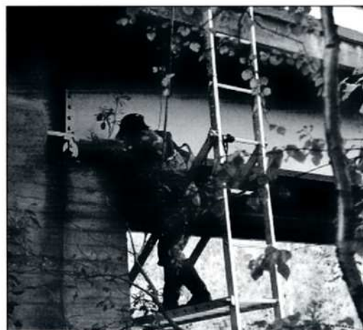
Lylykosken sillan panostaminen käynnissä panostustikkaiden avulla.
