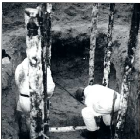
I-mallin taistelijaparin poteron pystytukia asennetaan paikalleen.
