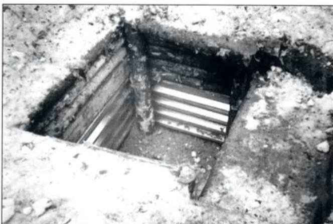
Valmis puulla ja pellillä lujitettu taistelijaparin potero.
