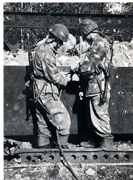
Pioneerit Jari Kuronen ja Mikko-Matti Harpela asentamassa panosta räjäytettävään kohteeseen.
