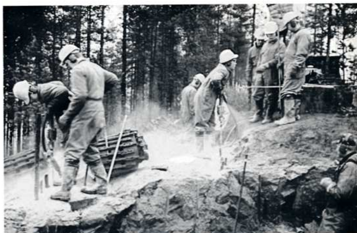
Tykkiaseman louhinta Ylämyllyllä.
