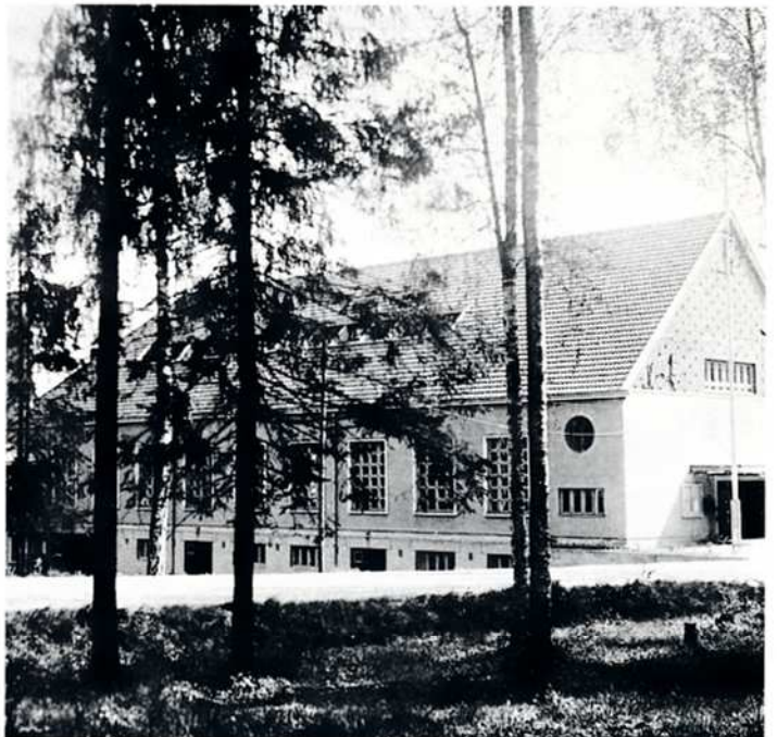
Vahtisotilaan mukaan ruokalarakennus on paikallaan. Sodan runnoma rakennus korjattiin ja yläkerrassa toimi kotinsa menettänyt sotilaskoti.
