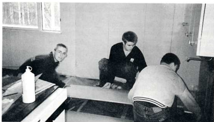
KarJP:n Jääkärikomppanian jääkärit Arto Jauhiainen, Mika Parviainen sekä Juha-Pekka Varis tekivät Veikko Tiilikaisen talon alapohjan mittavan peruskorjauksen Outokummun Kuusjärvellä. Kuvassa jääkärien reipasta ja iloista työskentelyä.
