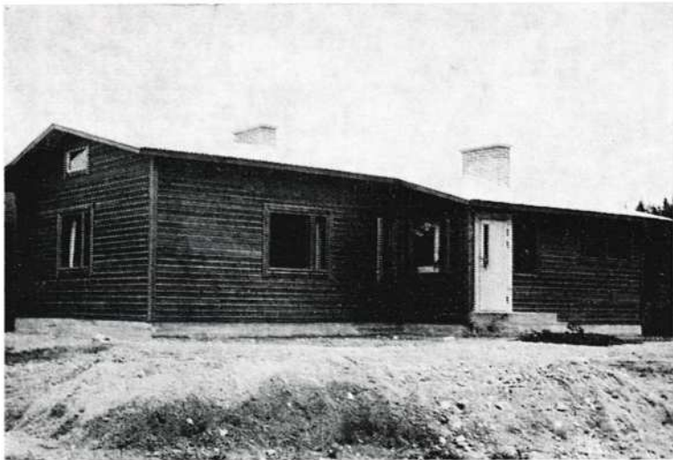
Vilho Tuonoselle rakentivat jääkärit uuden talon vesi- ja viemärijohtoineen sekä kaasulaitteineen.
